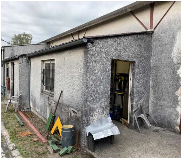
Photo 12 Locaux technique à l'arrière du bâtiment
