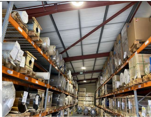
Photo 9 Charpente bâtiment de stockage
