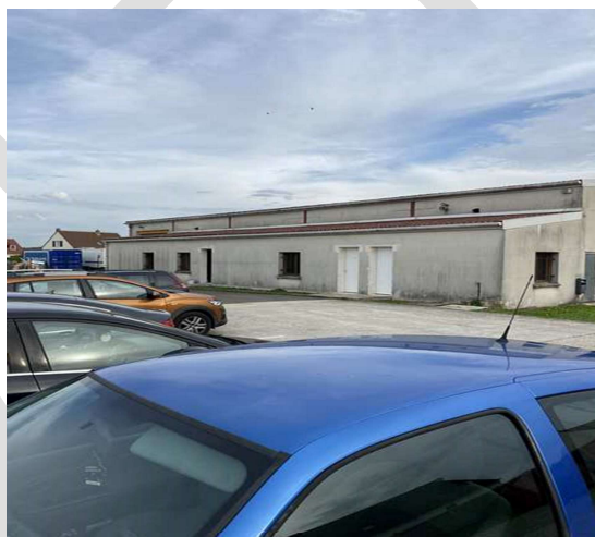
Photo 5 Toiture bâtiment de stockage
