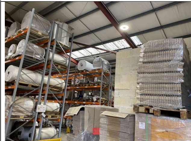
Photo 8 Charpente bâtiment de stockage
