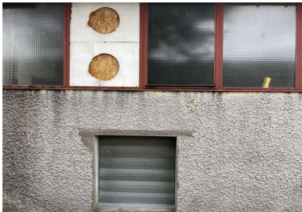
Photo 10 Façade locaux techniques
