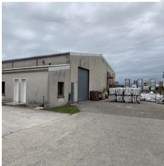
Photo 19 Façade avant du bâtiment de stockage
