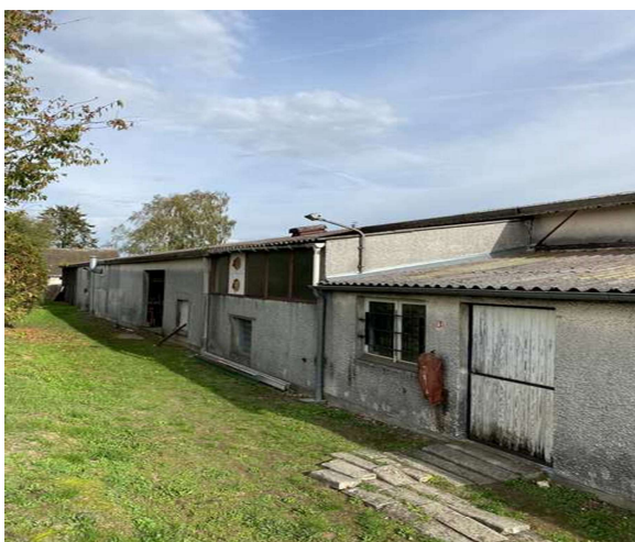
Photo 4 Toiture locaux technique
