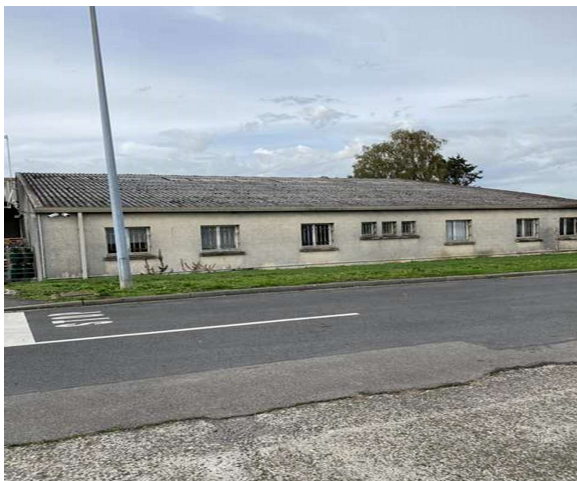
Photo 2 Toiture bâtiment fabrication
