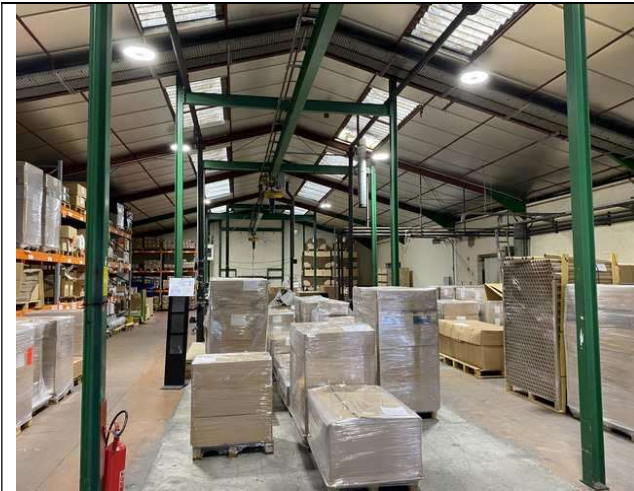
Photo 6 Charpente bâtiment de fabrication
