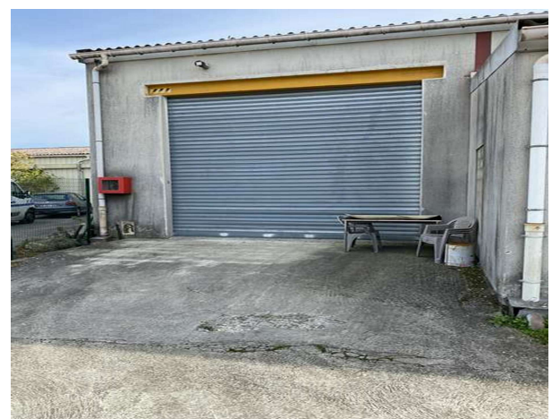
Photo 28 Porte rideau du bâtiment de stockage
