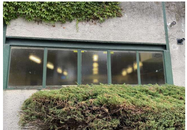
Photo 11 Châssis vitré de l'atelier
