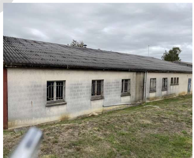
Photo 15 Façade avant du bâtiment
