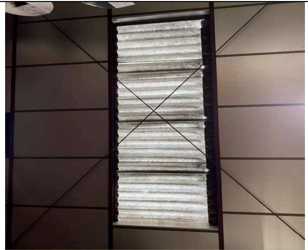
Photo 7 Charpente bâtiment de fabrication
