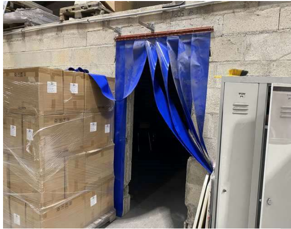
Photo 20 Mur de l'atelier
