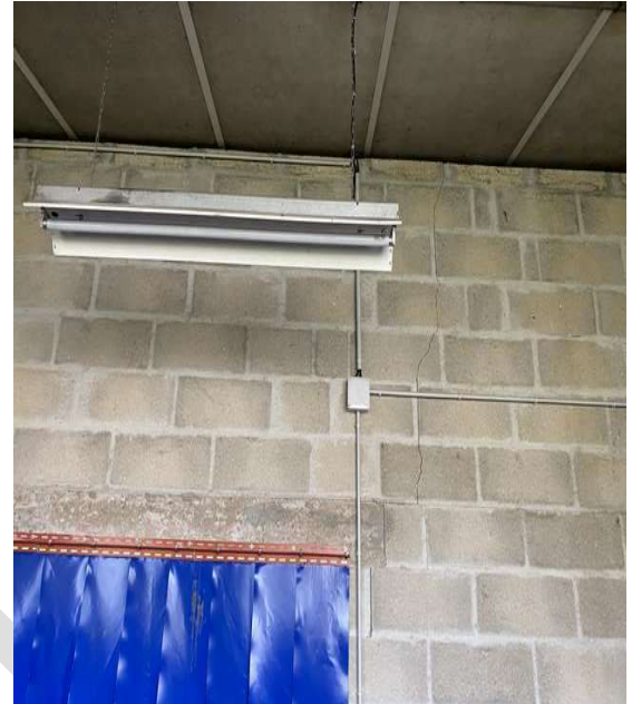
Photo 17 Mur intérieur des locaux techniques
