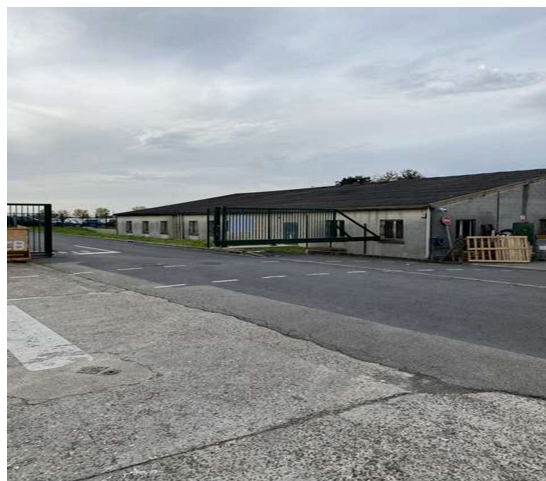
Photo 3 Toiture bâtiment fabrication
