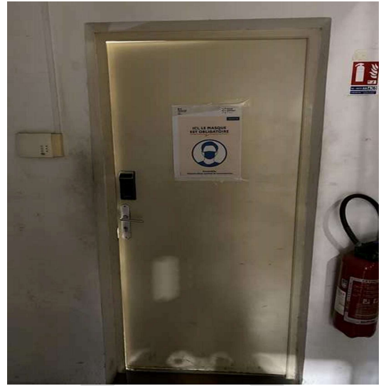
Photo 24 Bloc-porte des bureaux
