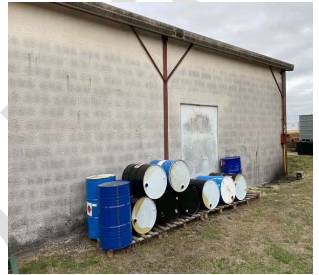
Photo 13 Façade arrière du bâtiment
