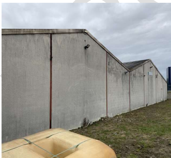
Photo 14 Façade de côté du bâtiment
